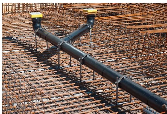
**[FIG. 1]** Esempio di un collare per la posa in una soletta in calcestruzzo a vista (immagine: SAMVAZ SA).
